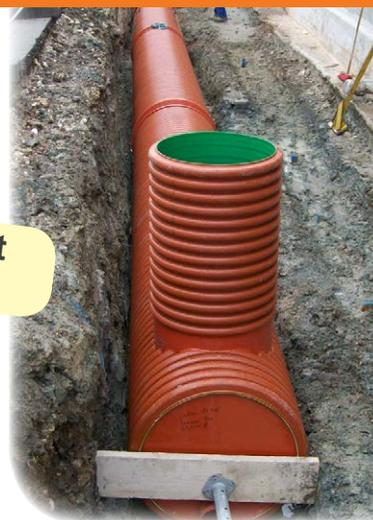
Wir produzieren unsere Tanks in SN8, SN12 und SN16 mit frei wählbarem Tankvolumen speziell nach den Wünschen unserer Kunden. **Die Anzahl, Durchmesser, SN-Klasse, Rohrart, Länge, Höhe sowie die Position der Zu- und Abläufe sind frei wählbar.**
