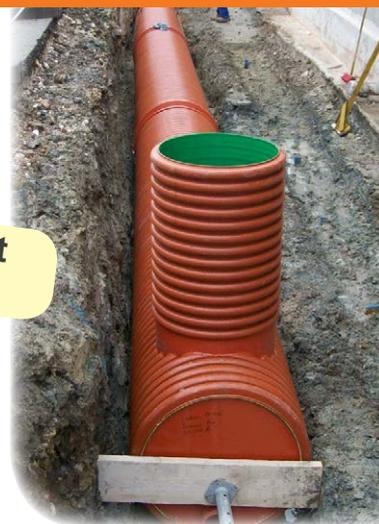
Wir produzieren unsere Tanks in SN8, SN12 und SN16 mit frei wählbarem Tankvolumen speziell nach den Wünschen unserer Kunden. **Die Anzahl, Durchmesser, SN-Klasse, Rohrart, Länge, Höhe sowie die Position der Zu- und Abläufe sind frei wählbar.**
